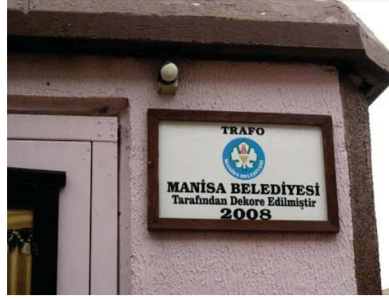
Şekil 25. Manisa, trafonun tabelası
