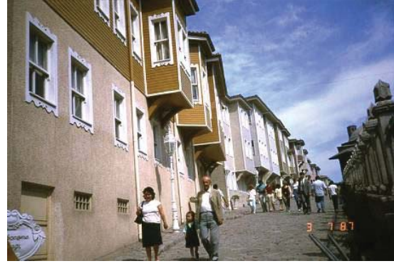
Şekil 6. İstanbul, Soğukçeşme Sokak, sonraki durumu
