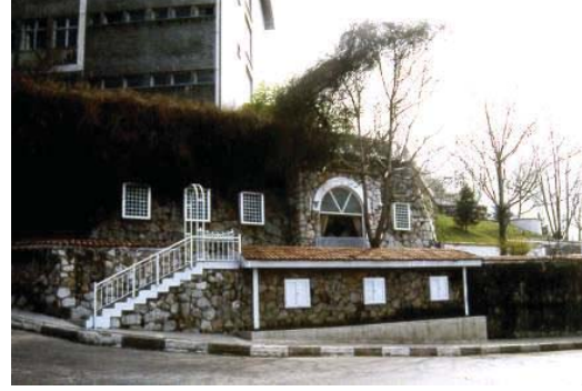
Şekil 20. Bursa, su deposu
