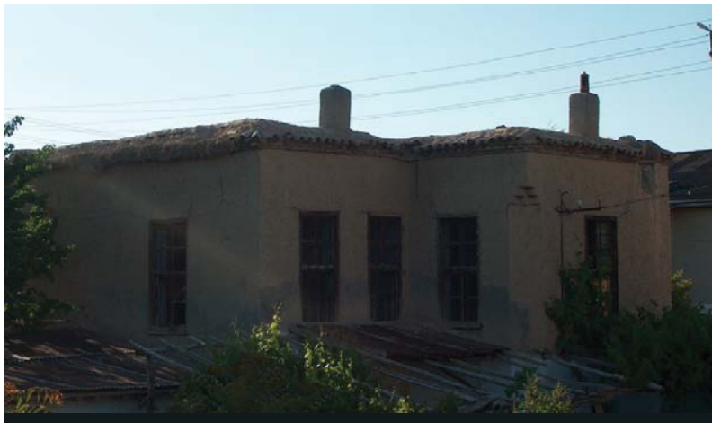
Şekil 2. Günümüzde de yaşamını sürdüren geleneksel düz damlı kerpiç malzemeden inşa edilmiş bir Konya Evi
