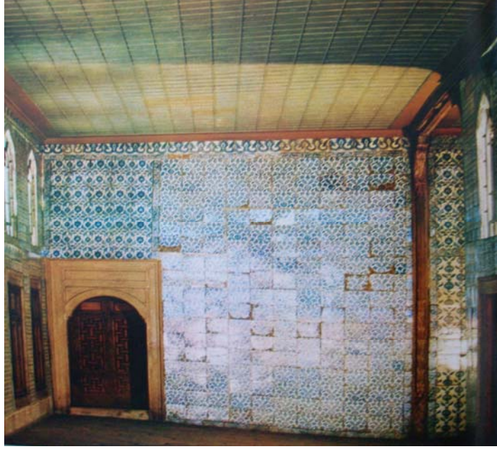
F.3.İç mekandaki çinilerin ortadan yok olmadan ki durumunu gösteren belgesel görünüş. ( Eldem -).
